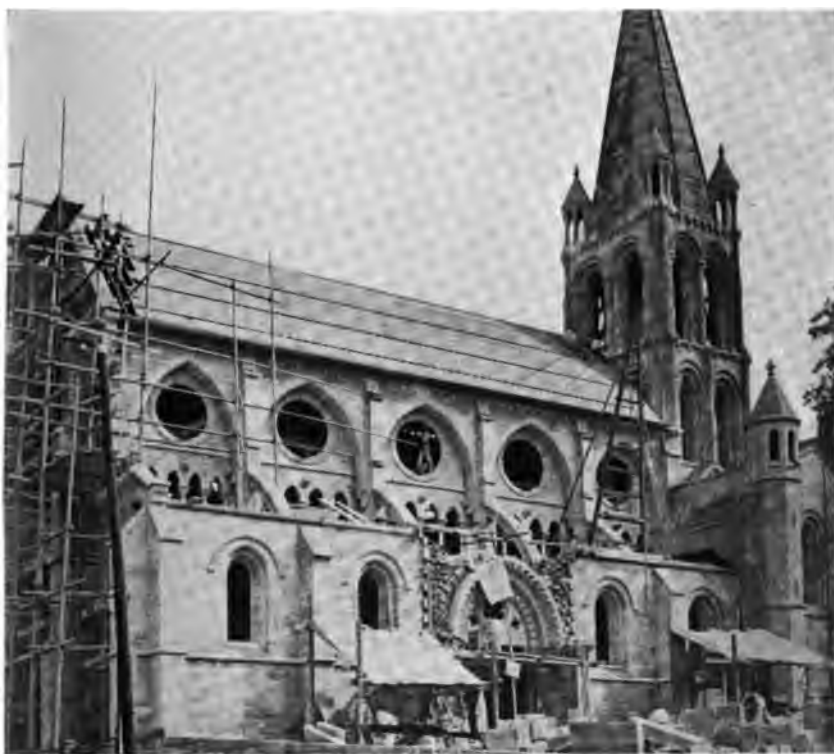
Fig. 50. — Type de flèche à écailles montée par encorbellement dans la région parisienne au XII e siècle. Clocher de Bougival (Seine-et-Oise).
